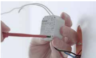
01 Conecta el DALI ACU BT a la red y al cable DALI
