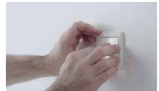
04 Coloca la carcasa del pulsador.
